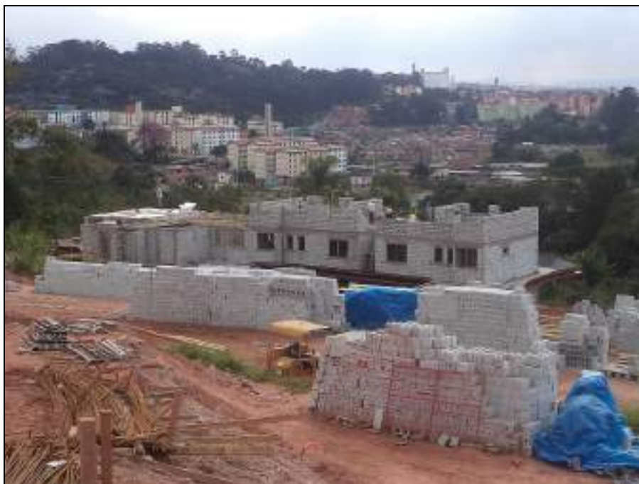
Foto 15 - Construção das unidades habitacionais do Conjunto Habitacional José Maria Amaral
