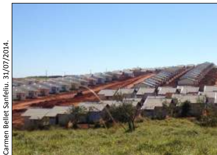
Foto 8 – Exemplo de empreendimento do Programa Minha Casa Minha Vida FAR - Faixa 1 – Conjunto Habitacional Jardim João Domingos Netto – Presidente Prudente/SP.
