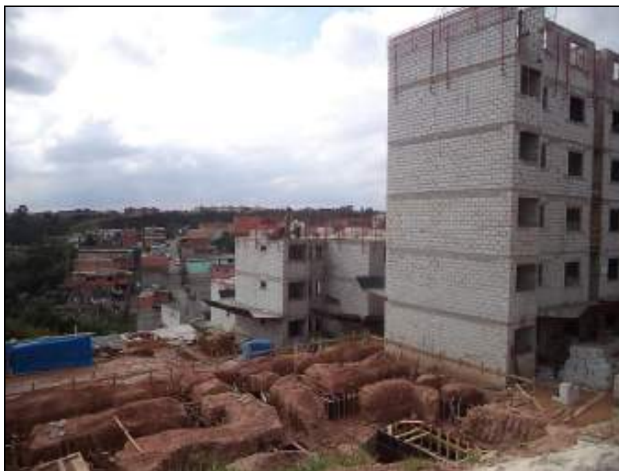
Foto 16 - Construção das unidades habitacionais do Residencial Florestan Fernandes
