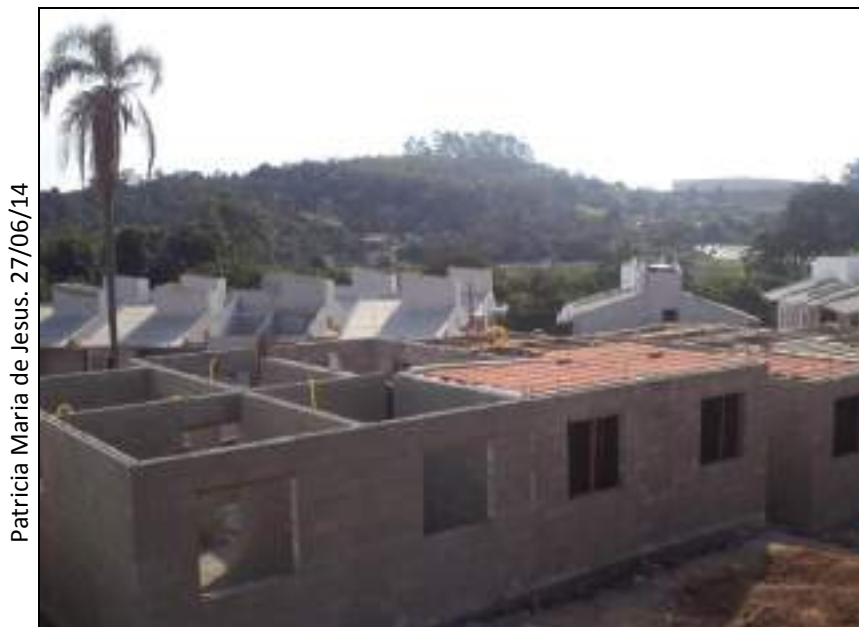
Foto 19 - Construção das unidades residenciais do Condomínio Residencial Zorilda Maria dos Santos
