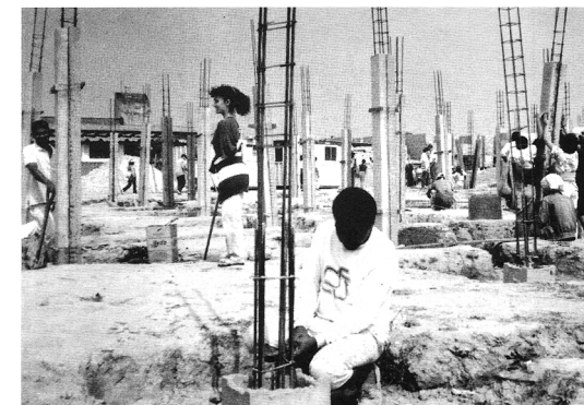
Imagem 74: Fundações e pilares no mutirão de Vila Nova Cachoeirinha
