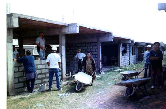
Imagem 73: Construção dos vedos no mutirão Vila Nova Cachoeirinha
