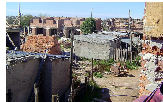
Imagem 69: Canteiro de obras da cooperativa Covilacar
