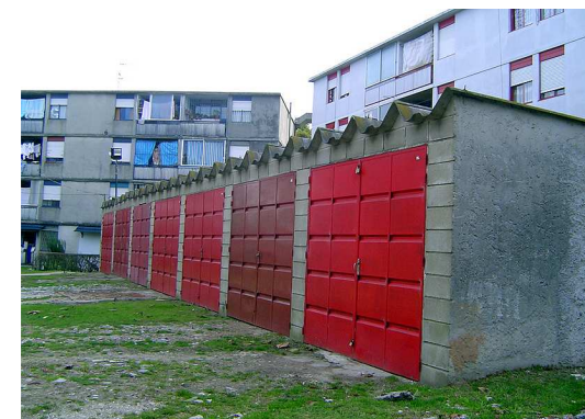
Imagem 55: Garagens na “Zona 1” e no Cingapura Vila Nova Cachoeirinha
