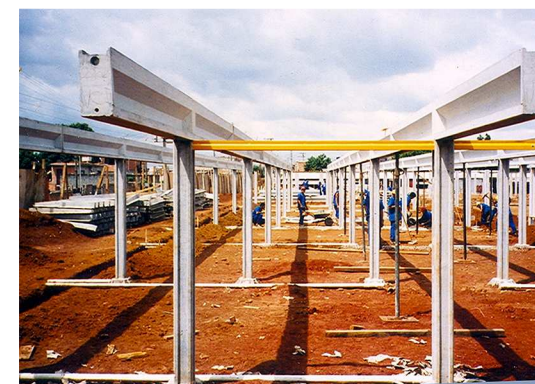
Imagem 75: Montagem de escola com componentes pré-fabricados do Cedec Foto de Reginaldo Ronconi
