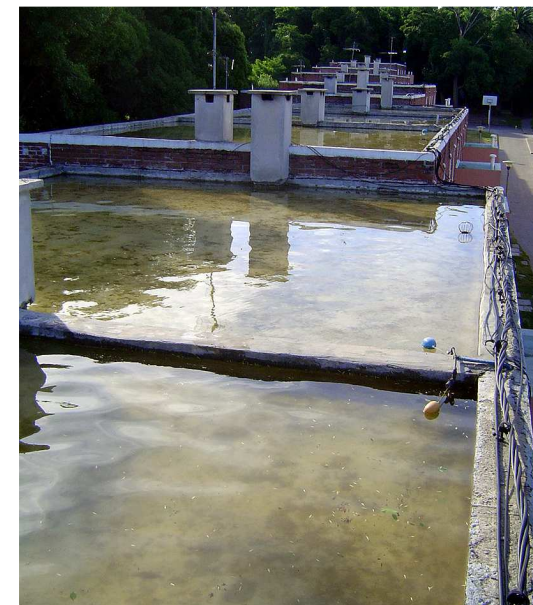
Imagem 66: Isolamento térmico com água na cooperativa Tacuabé.
