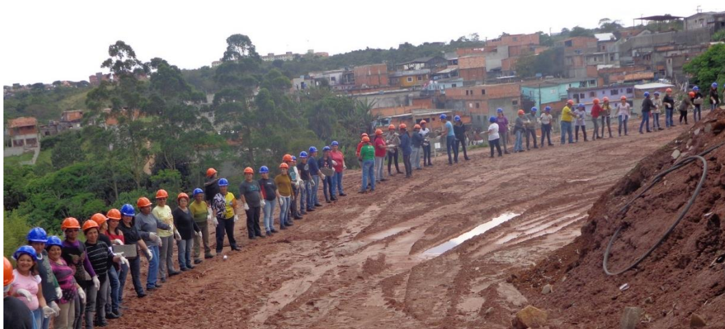
Figura 27 – Transporte de material em mutirão – “formiguinha”
