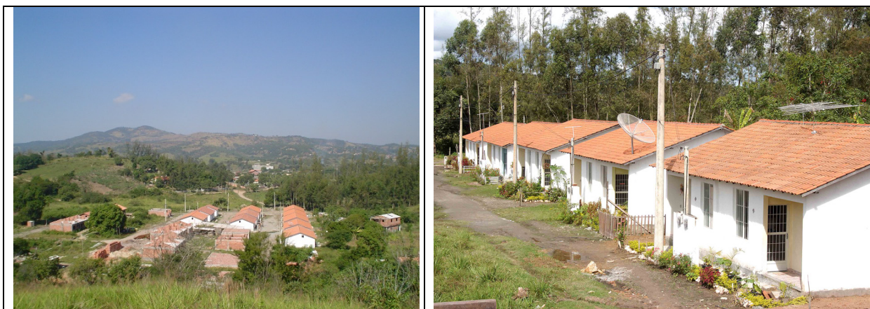
Cooperativa Ipiíba. Foto 1: Vista geral ainda na segunda fase de construção (entre 2003 a 2005). Fonte: Acervo FBR
