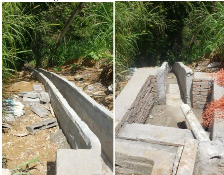
Figura 18: Escada drenante em fase de obra
