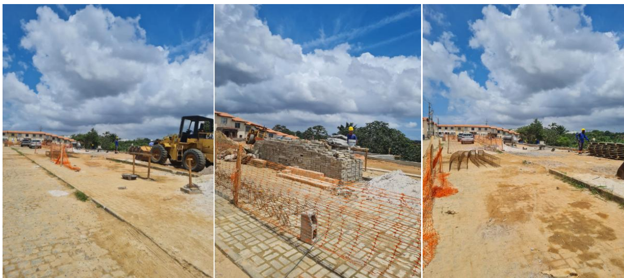
Figura 19: Obras da quadra de esportes, parque infantil e academia ao ar livre em fase de obras pela CONDER
